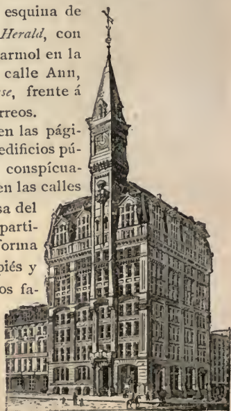
Edificio de la "Tribune."—Nueva York. total ascendió á $7,000,000. Se
